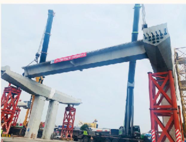
指挥下，小箱梁下移至货车，并进行加固，货车开始将小箱梁运送出厂，按照预定踏勘的运梁线路，运送至指定位置，1月13日，随着第一片重达140余吨的箱梁稳稳地落在墩台上，绍兴智慧快速路（二环北路标段）首片箱梁架设成功，正式拉开了智慧快速路上部结构施工的序幕。
