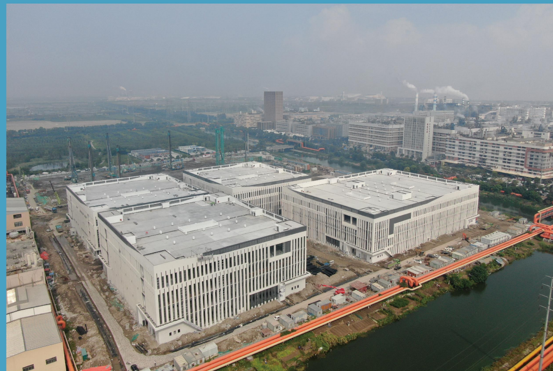
天工集团承建的轻纺智谷数字工业园区一期EPC总承包项目实景
