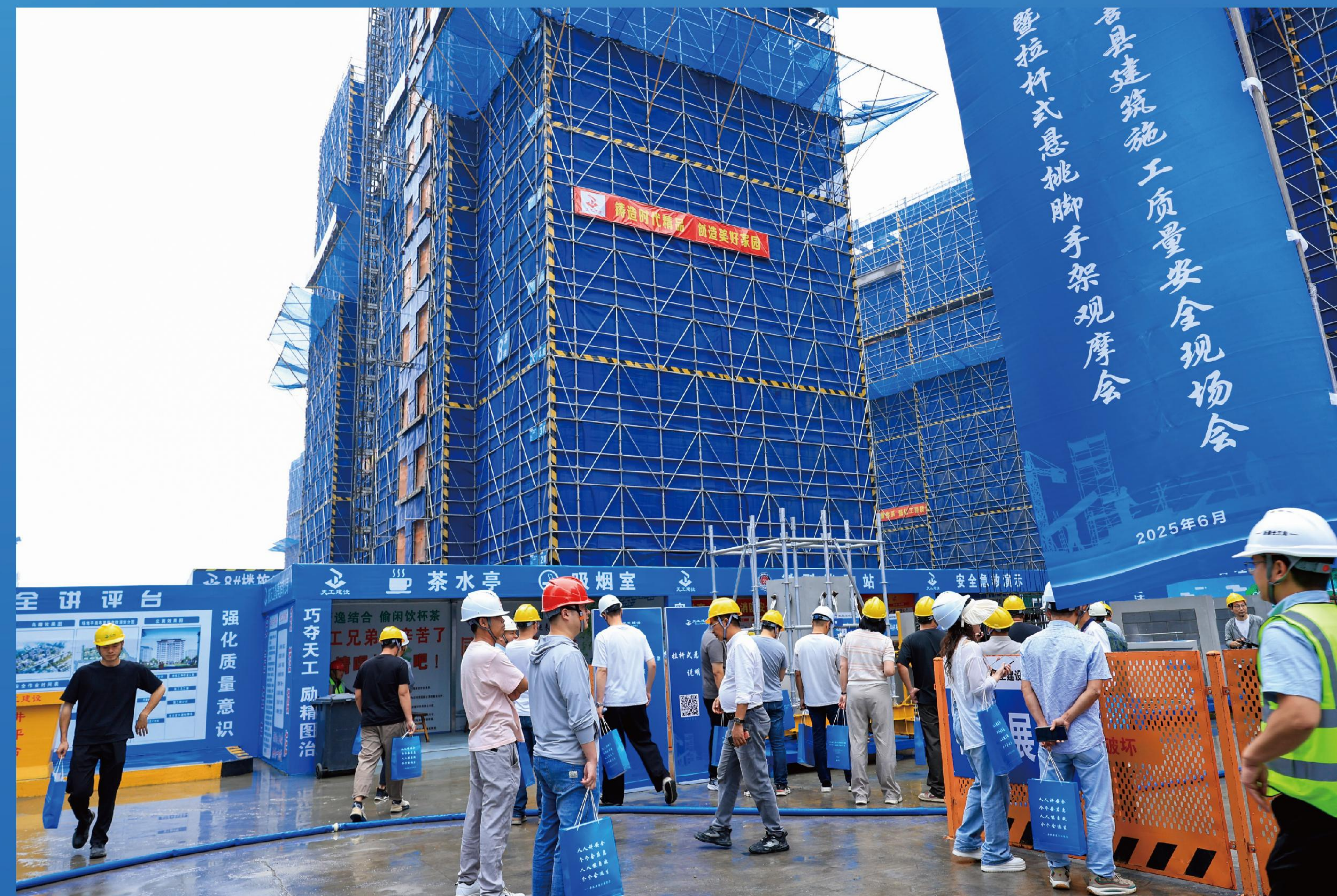
天工集团干窑小学东侧安置房项目施工质量安全观摩会
